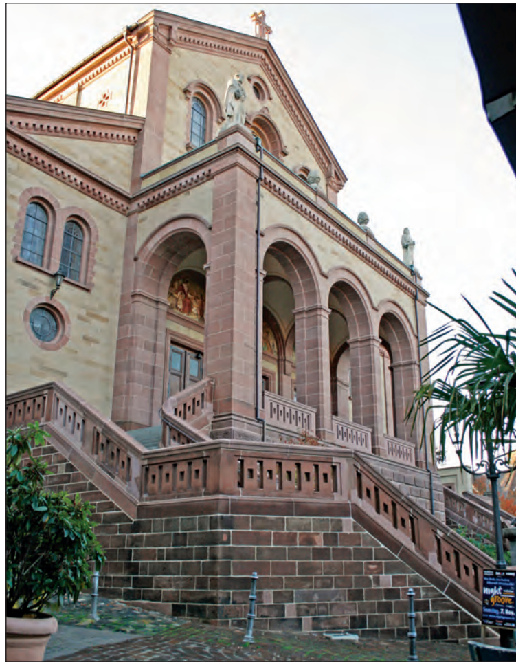
Die Außentreppe der Weinheimer Stadtkirche St. Laurentius wurde in ihren ursprünglichen Zustand wieder errichtet.
